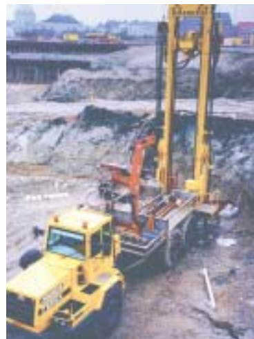
Brøndborefirmaet Brøkers borerig på opgave der, hvor Operaen ligger i dag. Der bores til grundvandssænkning
