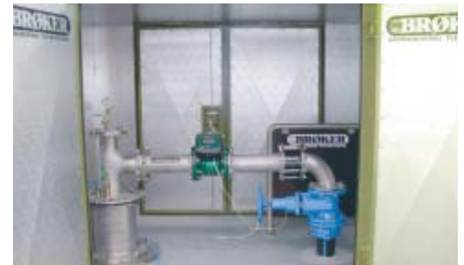
- Vi producerer, hvad der har med vandværker at gøre. Men kun på den udvendige side - altså råvandet. Vores serviceafdeling udfører flowsyring, tryksyring, renblæsning, renpumpning, prøvepumpning, samt montage af pumper og råvandstationer, som vi selv producerer, forklarer Thomas Brøker. Billedet viser en ny type overjordisk råvandstation
