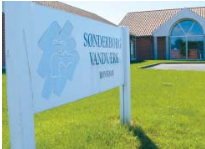
Vand-Schmidt var både rådgiver og totalentreprenør på Rønsdam-projektet. Her er tale om et nyopført vandværk.
