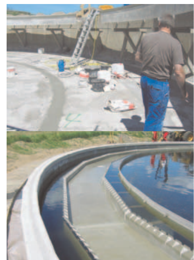
Under og efter renovering af bassin på et renselanlæg
