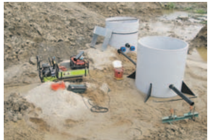
- Ret beset er ingen opgave for stor for os. Vores erfaring inden for spildevand og drikkevandssektoren er stor - ikke kun som producerende virksomhed, men også i forbindelse med montageopgaver. I konstruktions- såvel som serviceopgaver har MARSØ ligeledes en stor erfaring, forklarer Martin Krogh
