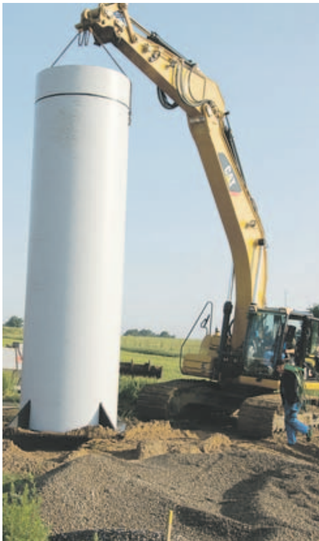
En brønd fra MARSØ sættes på plads i landskabet
