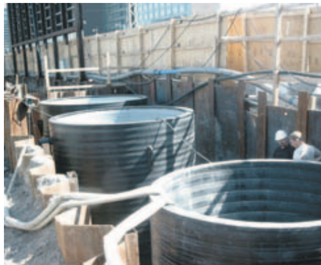
Toppen af tankene slutter i forskellige niveauer på grund af det projekterede trappeformede landskab.
