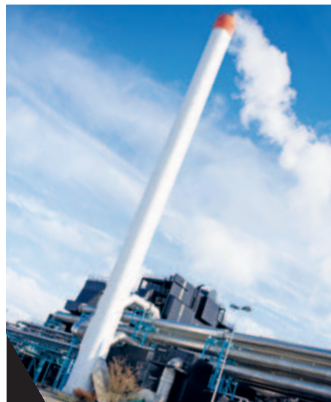
Når borgerne i Nyborg ser røg fra skorstenen hos Kommunekemi, så kan de lune sig ved tanken om, at der produceres varme nok til at forsyne samtlige husstande i Nyborg
