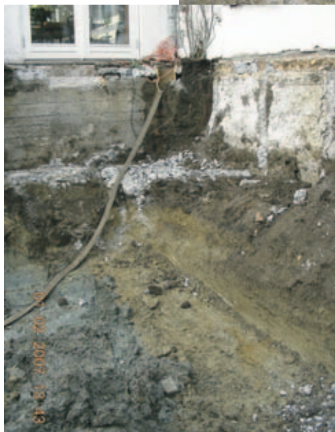
Forurennet jord kan oprenses mekanisk eller biologisk. Den biologiske metode har den fordel, at "livet kan leves videre" på ejendommen, idet der ikke skal graves store huller, mens oprensningen foregår. Af samme årsag er biologisk rensning en konkurrencedygtig løsning økonomisk
