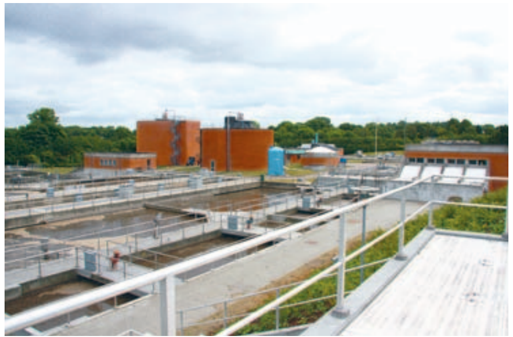
Roskilde Kommune sætter fokus på vedligehold, og Roskilde Forsyning har købt en LOGIHOLD SQL version til brug for vedligehold af diverse anlæg (bl.a. vand/energi og el/spildevand). Her ses det store anlæg Bjergmarken Renseanlæg
