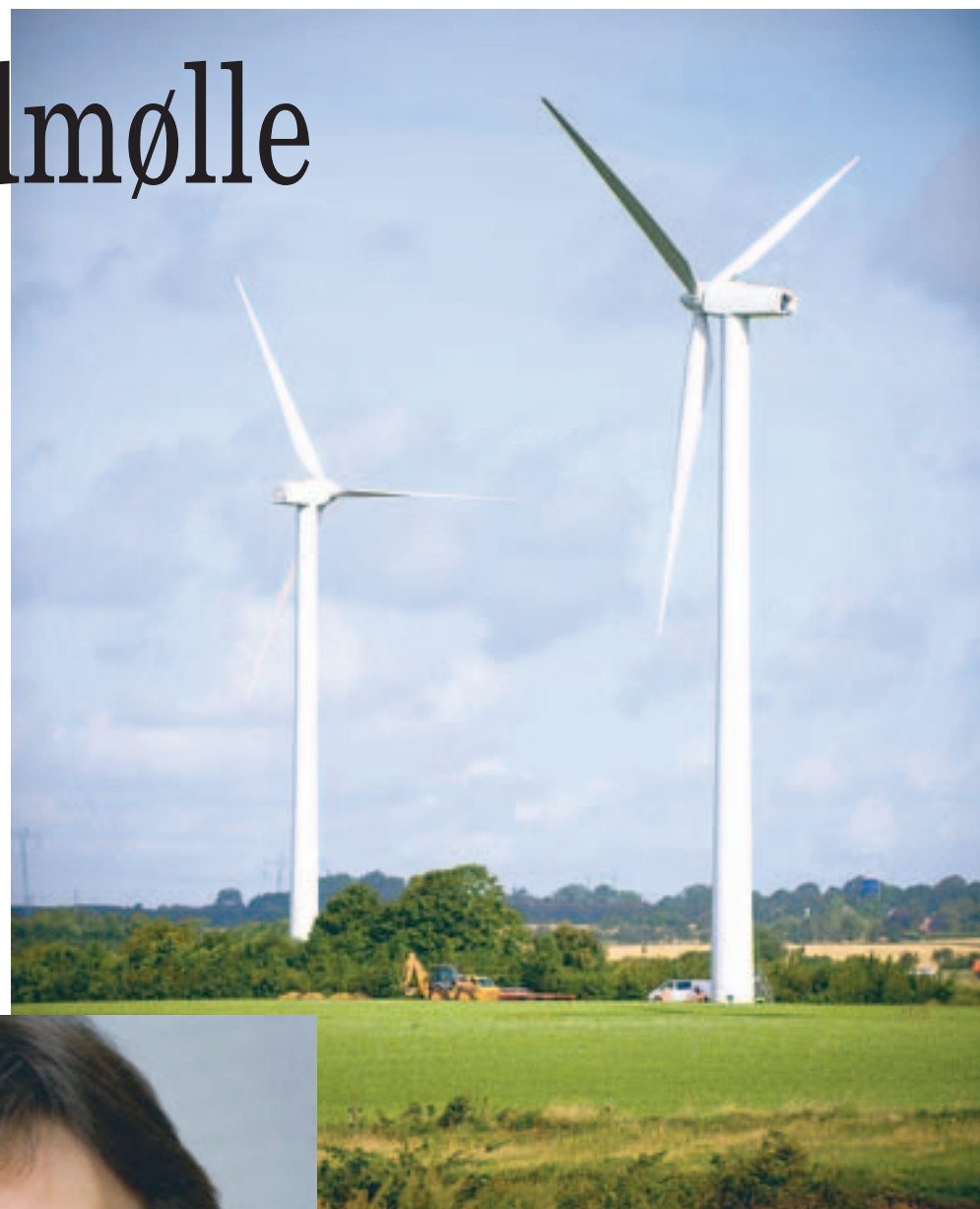
Energi Danmark Vind ApS har erhvervet to nyopførte vindmøller af typen Vestas V52. Møllerne har et nominelt output på 2 x 850 kW. Den beregnede årsproduktion er på 4.000.000 kWh.
