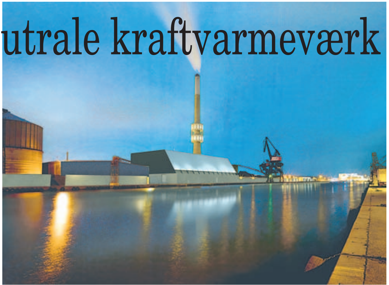
Energi Randers har ombygget sit kraftvarmeverk på havnen i Randers, og værket kan nu fyre med kul og biobrændsel i et mix af alt fra 100% kulfyring til indfyring af 100% biomasse
