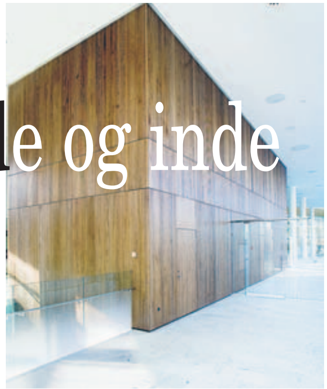
Eksempel på beklædning af dobbelt høje vægflader ved anvendelse af Barsmark MA52 paneler med lamel perforering, sort ubrændbar kerne og amerikansk valnød på overfladen. Aller Media A/S domicil i København.
