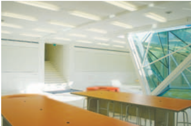
På væggene i det nye kælderareal på Munkegårdsskolen ses Barsmarks MA32 paneler med lamel perforering og hvid lak monteret på væggene. Der er inkorporeret skjulte døre for let adgang til de bagvedliggende VVS installationer.
