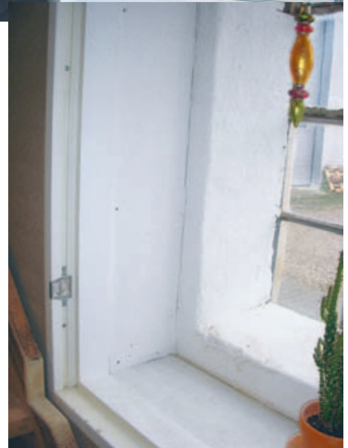
Man ser tydeligt den tykke væg af ubrændte lersten, mens hampeisoleringen er dækket af pudset
