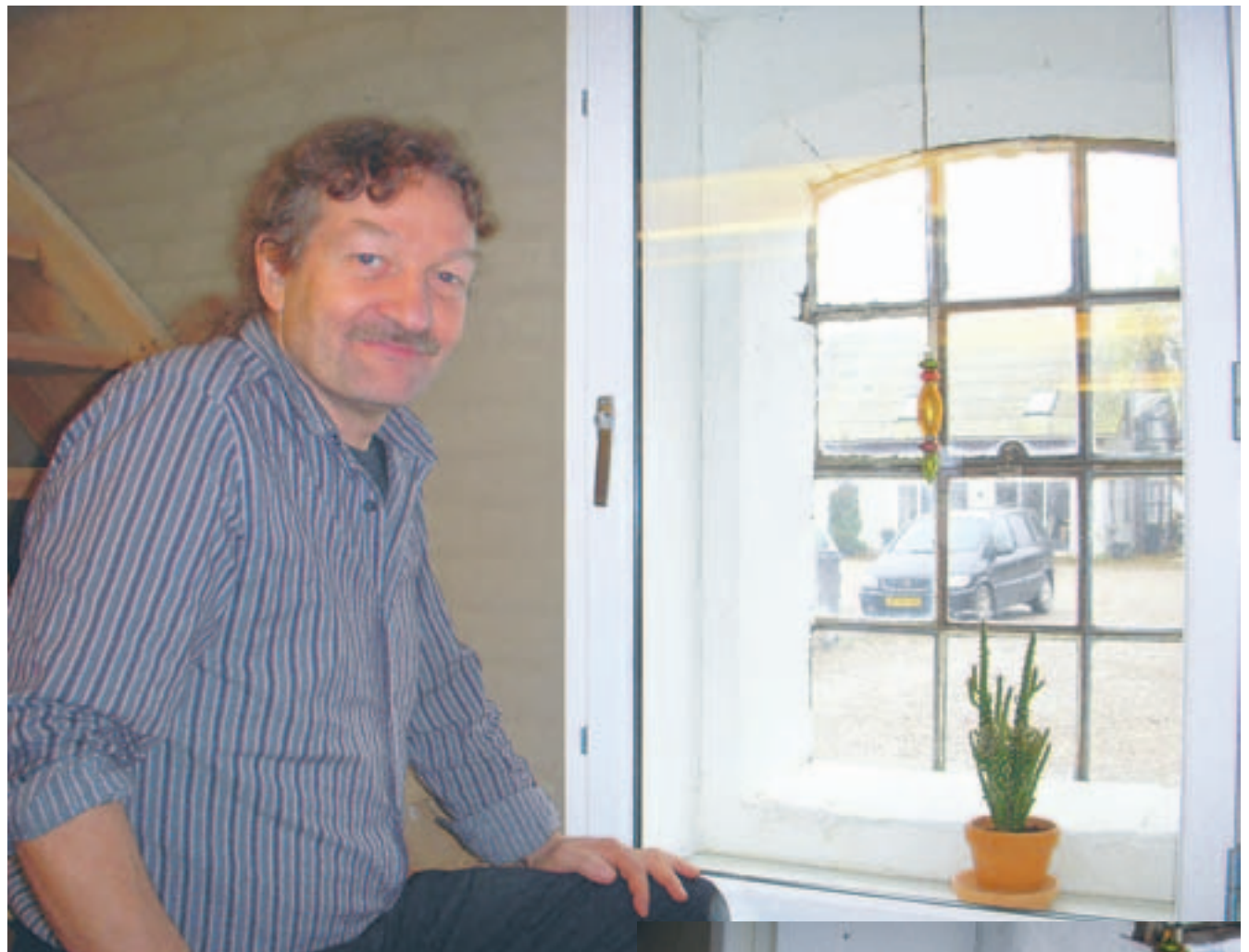
I Egen Vinding og Datters administrationsbygning – en ombygget svinestald – har man beholdt de oprindelige ydervinduer, men muret ny indervæg med ubrændte lersten og hampeisolering og et indre vindue af eget fabrikat
