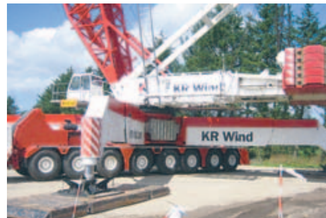
Energi Danmark har fået rejst og skal have rejst møller flere steder i Danmark. Her er en kran parat til at rejse en mølle i Løndrup
