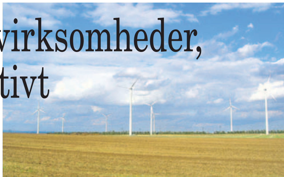
Alle vindmøller under Global Wind Powers Technical Management får et større servicetjek to gange om året. Inspektionen foretages af vindmølleproducentens serviceteam i samarbejde med Global Wind Powers egne teknikere. Her ses et udsnit af møllerne ved Windpark Katzenberg i Tyskland. Vindmølleparken består af 14 møller af typen Vestas V52
