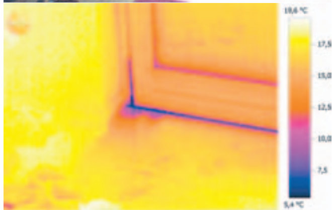
Termografi eller termofotografering afslører varmetab i bygninger
