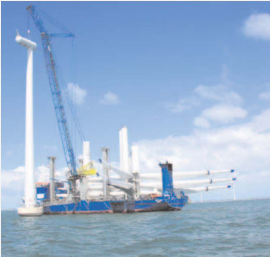
Kan vingerne bære på store vindmølleprojekter, efter svenskerne har besluttet at tillade ti nye atomreaktorer? Billedet er fra E.ONs Rødsand 2 (Foto: Jesper Winther Andersen)
